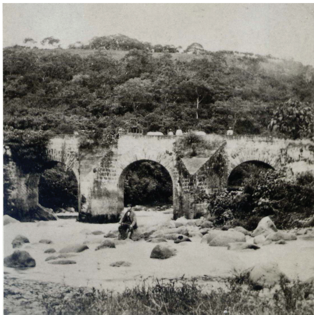
Figura 5. Puente sobre el río Virilla, en el límite entre San José y Heredia. Fuente: Otto Siemon
