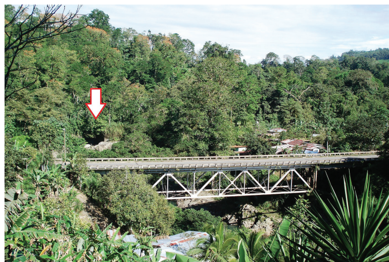
Figura 13. Vista del puente (A), así como de la cercha inferior (B). En 13B, la flecha indica la ubicación del antiguo puente de metal.
